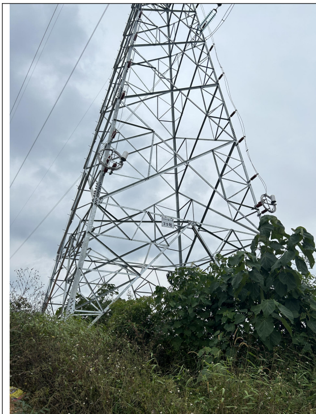
杆塔施工区植被恢复情况图
