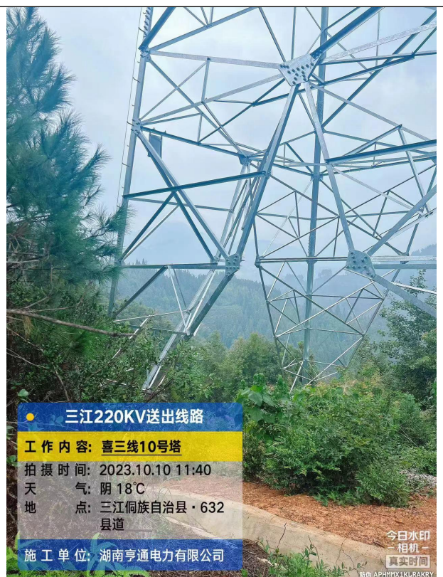
杆塔施工区截排水沟
