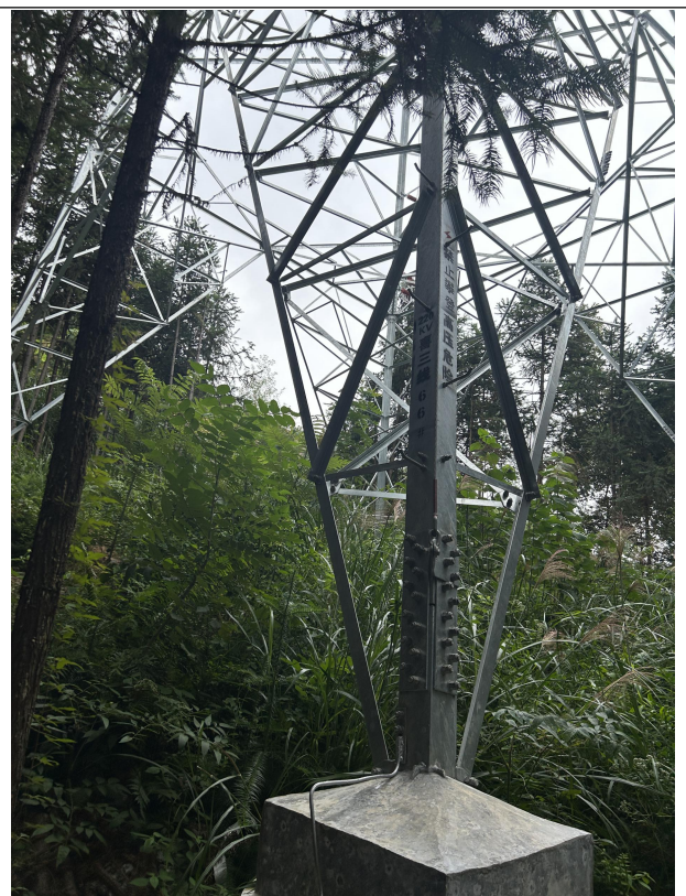
杆塔施工区植被恢复情况图
